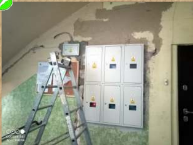
Bytomska 28a - remont instalacji elektrycznej części wspólnej
