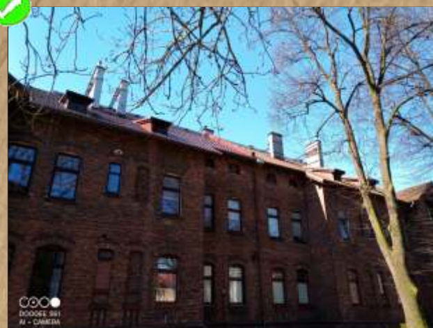
Bytomska 5 - założenie ław kominiarskich i wykonanie wjazdu dachowego
