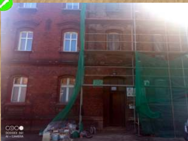
Górnicza 3 - fugowanie elewacji
