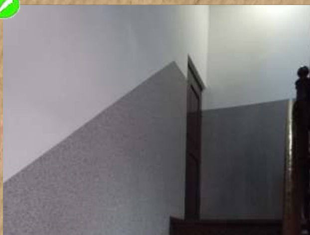
Kościuszki 1 - malowanie klatki schodowej
