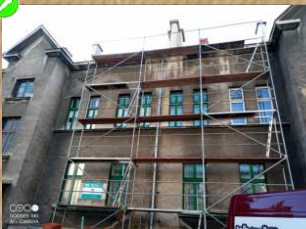
Wyspiańskiego 2 - remont części dachu z dachówki
